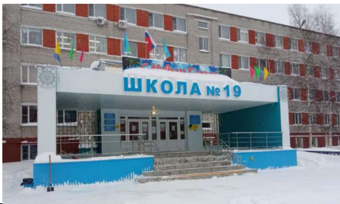
Фото №1. Главный вход в здании школы
